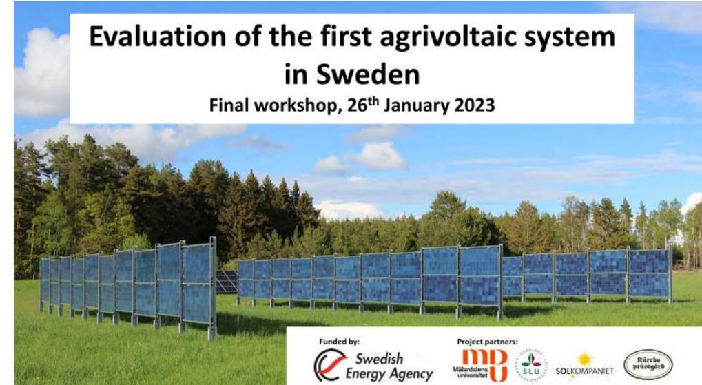
APV-Forschungsanlage Kärrbo; ca. 30 kWp und 10m Reihenabstand.
