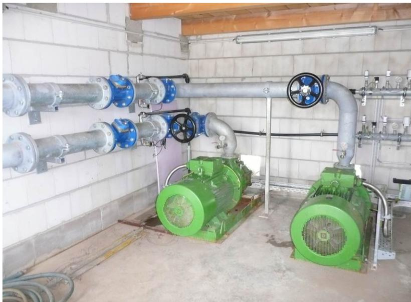
Abb. 9 Zwei Pumpen mit je 60 kW<sub>el</sub> pumpen Wasser aus einem Kiessee.
