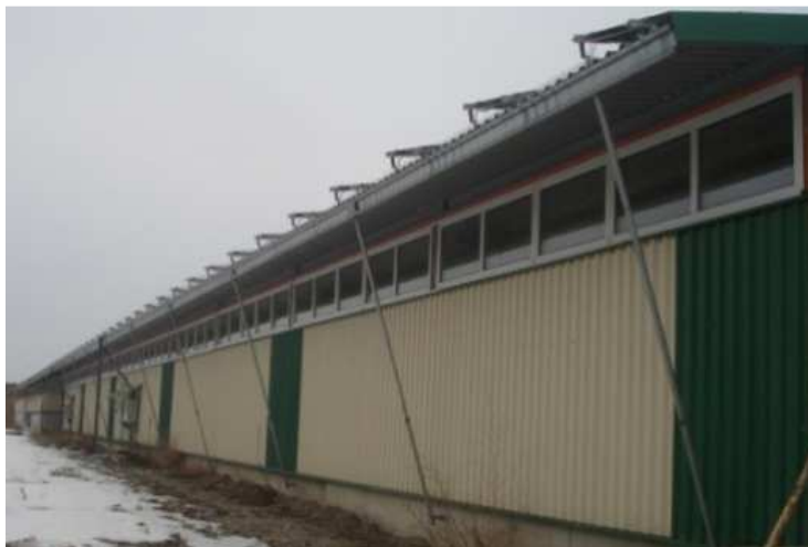
Foto: Fensterflächenanordnung zur Verminderung von Licht und Wärmestress in einem Deckstall
