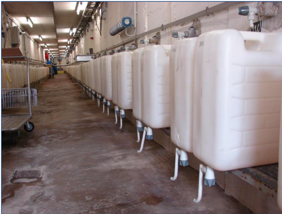
Lysimeterkeller mit Sickerwasserauffangananlage
