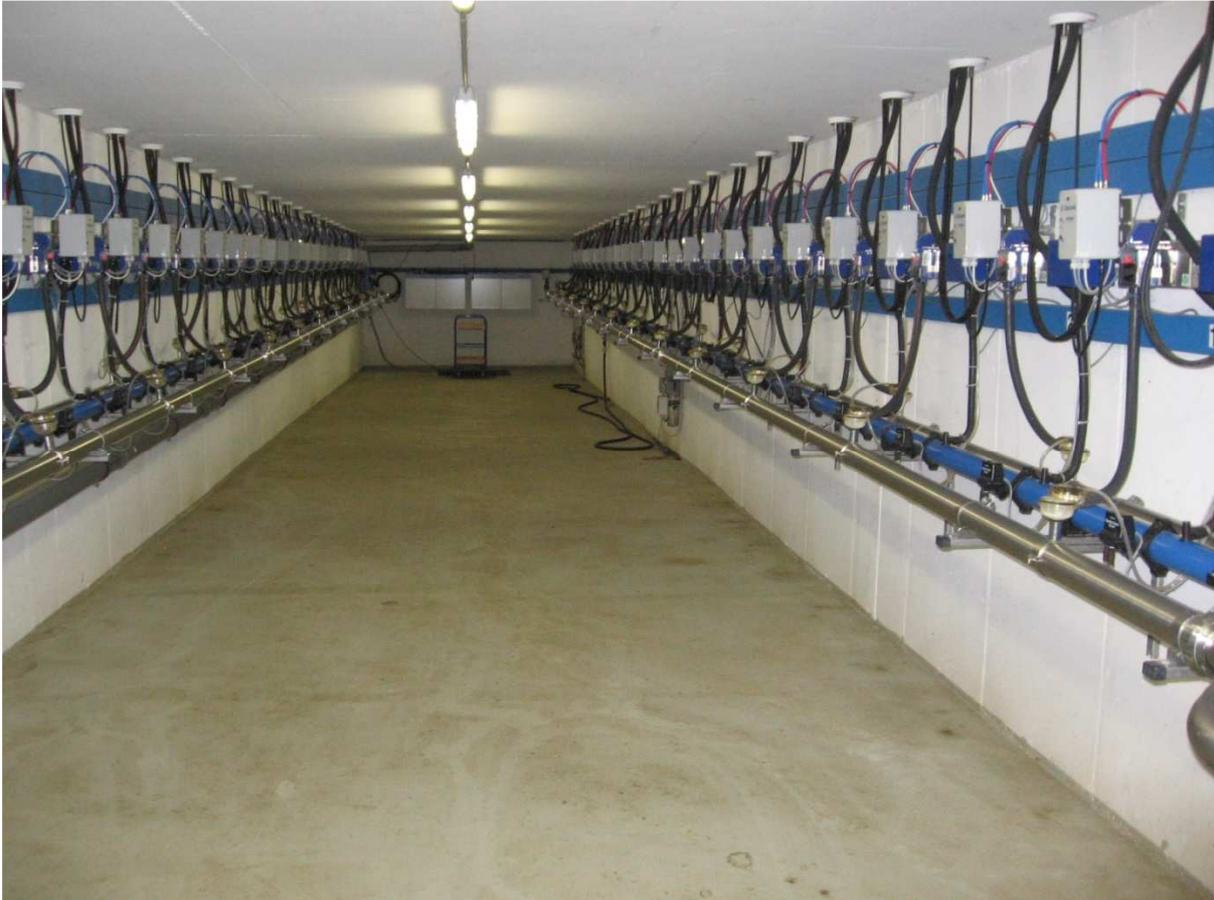
**Abbildung 4: Die Verlagerung empfindlicher Bauteile in einen Keller unter dem Melkstand ist ein interessanter Ansatz zur Verringerung der Wartungskosten. Es muss im Einzelfall abgewogen werden, ob sich das im Vergleich zum höheren Investitionsbedarf rechnet.**
