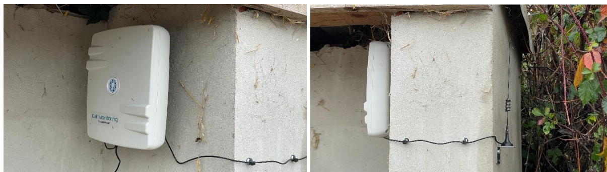
Abbildung 2: Anbringungsvariante für das Gateway im Außenbereich
