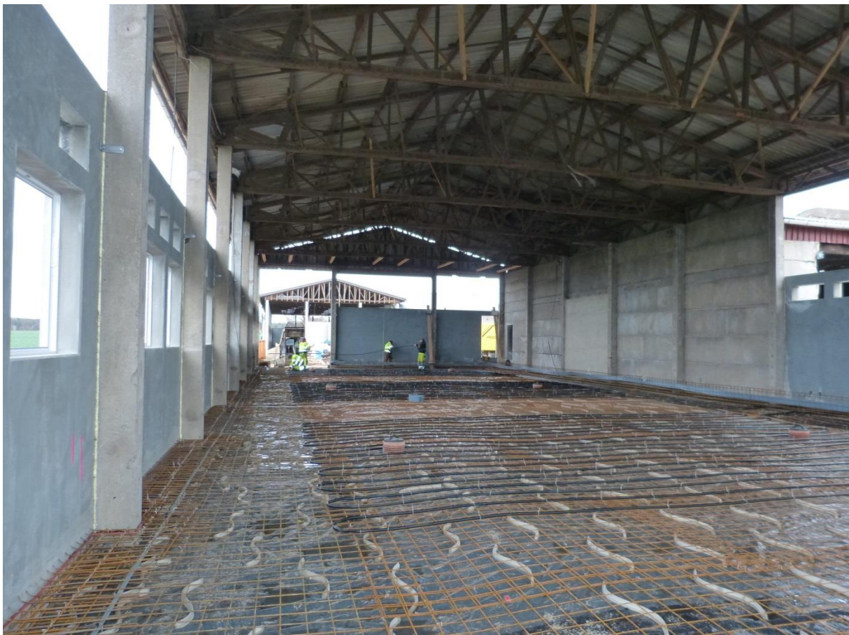
Abbildung 1: Die Kälteleitungen wurden in den Abteilen vollflächig in Beton gegossen.
