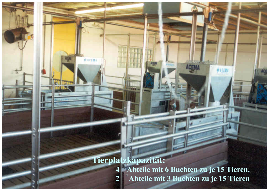
Abb. 18: Mastabteil im Prüfbereich
