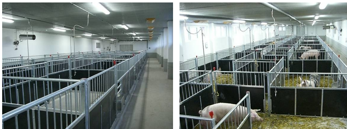
Abb. 25: Remonte-Jungeberstall nach Umbau und Neubelegung
