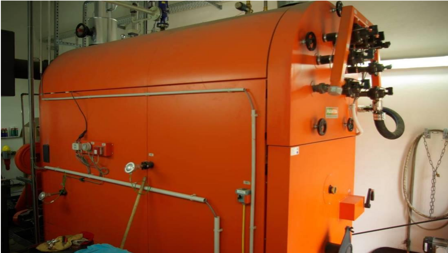
Biomassekessel MAWERA, Lehr- und Versuchsgut Köllitsch
