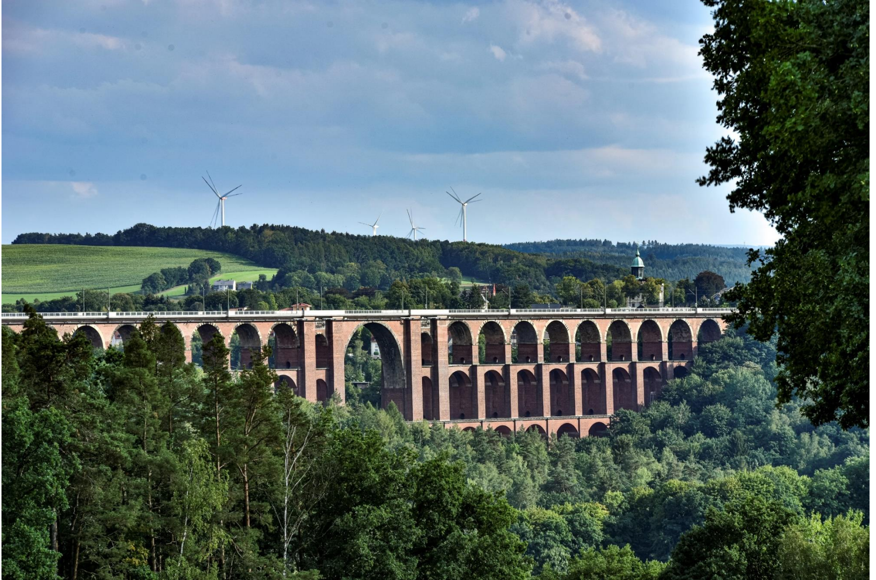
Göltzschtalbrücke bei Reichenbach im Vogtland
