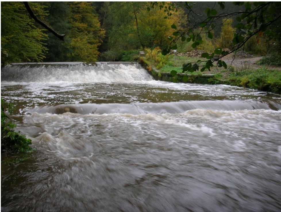
Abb. 2: Streichwehr der Wasserkraftanlage im Lachsbach. Hohe Durchflussmengen im Lachsbach und hoher Wasserstand in der Elbe waren günstige Voraussetzungen für einen zeitigen Beginn des Lachsaufstiegs 2013.
