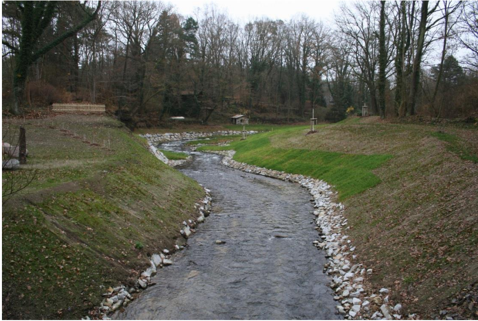
Abbildung 1: Rückgebautes Wehr an der Grünmetzmühle und Umgestaltung zu einer Sohlgleite an der Pulsnitz
