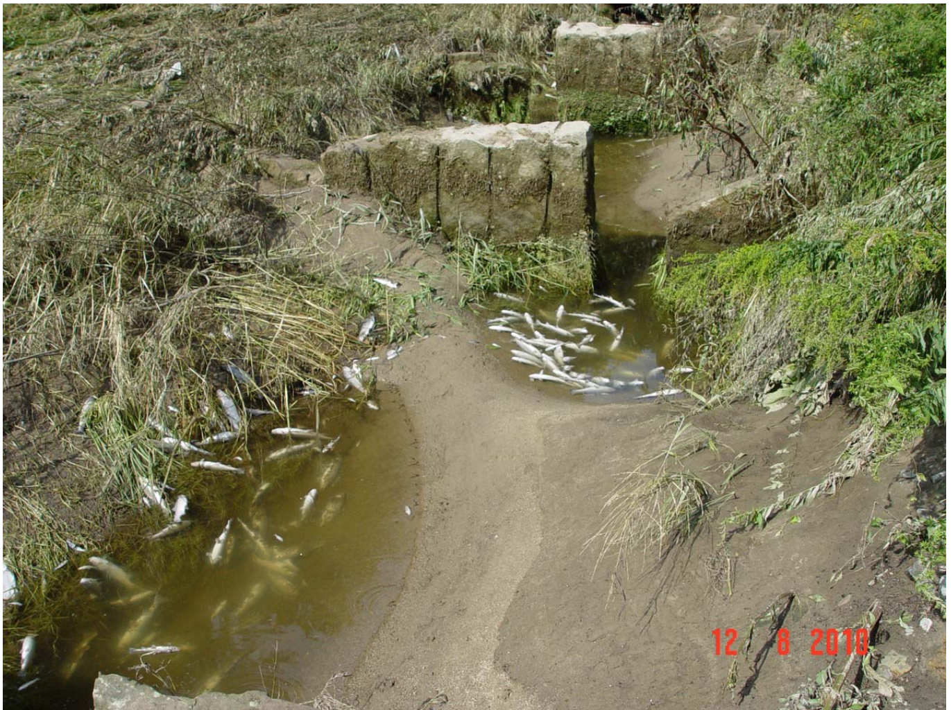
Abb. 4: Zugeseetzte Becken des Fischaufstiegs im mittleren Bereich mit toten Forellen
