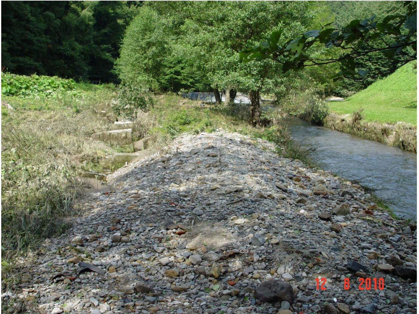
Abb. 1: Mit Geröll versetzter unterer Abschnitt des Fischeaufstiegs
