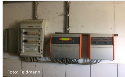
Alte Regeltechnik der Lüftungsanlage
