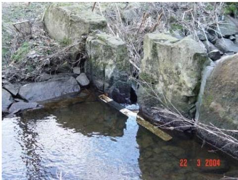
**Abb. 49:** Verstopfung im Fischweg der Wasserkraftanlage Schmidhammer
