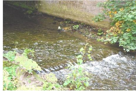
**Abb. 24:** Sohlpflasterung Brücke Kohlmühle
