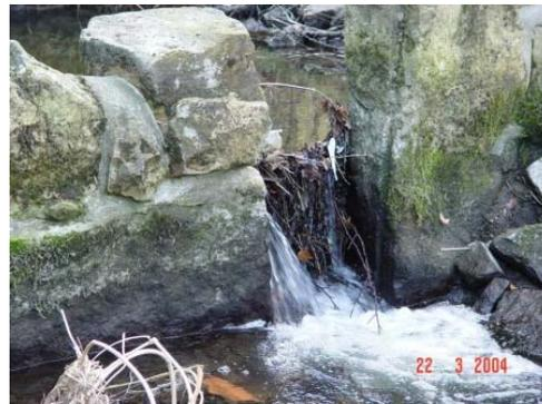
**Abb. 50:** zugesetzter Passageschlitz im Fischpass Schmidhammer
