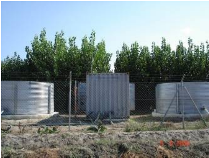
Schmutz- und Abwassercontainer sowie Container mit Prototyp
