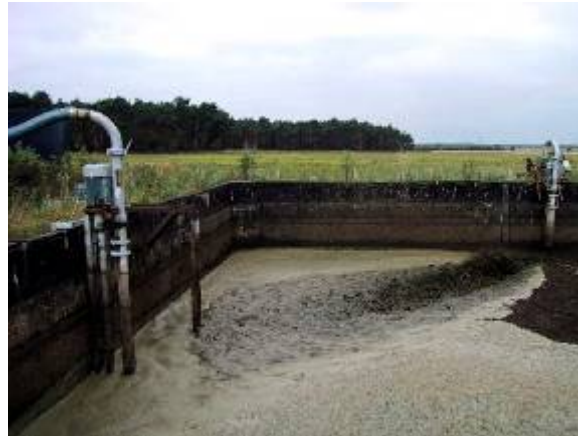
Belüftungsrührwerke und Güllepumpen
