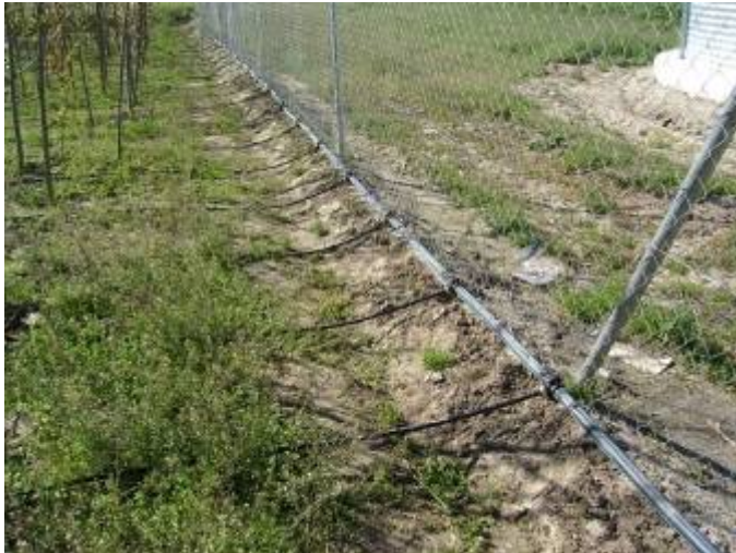
Beregnungsmodul II Leitungssystem
