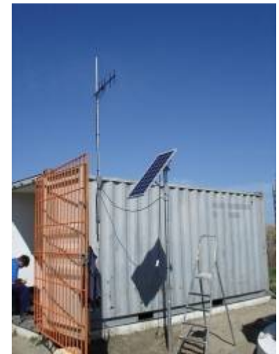
Solarmodul mit Richtantenne
