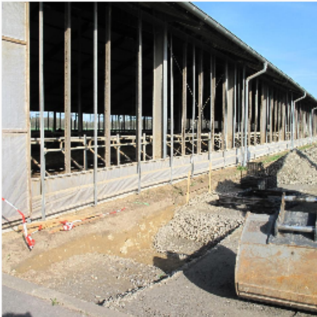
Baustelle Stall; Quelle: LfULG
