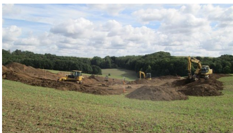
Abtrag des Mutterbodens und Einbau der Sickerdränage im September 2012 (© LfULG).
