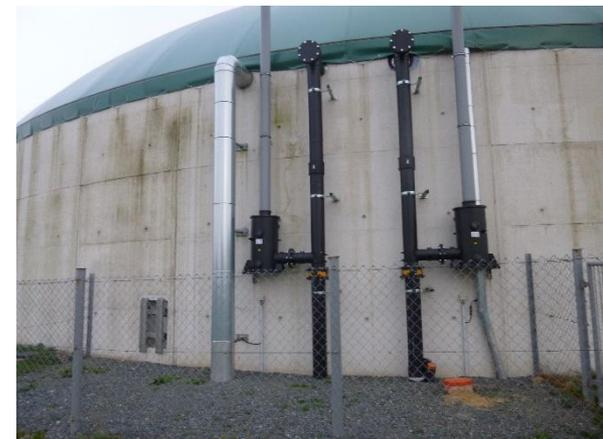
Dichtheit aller gasbeaufschlagten Anlagenteile, einschließlich der Funktionsfähigkeit und Dichtheit von Armaturen, ist durch eine geeignete Person nach TRAS 120, vor Inbetriebnahme und danach alle drei Jahre zu prüfen und zu bewerten.
