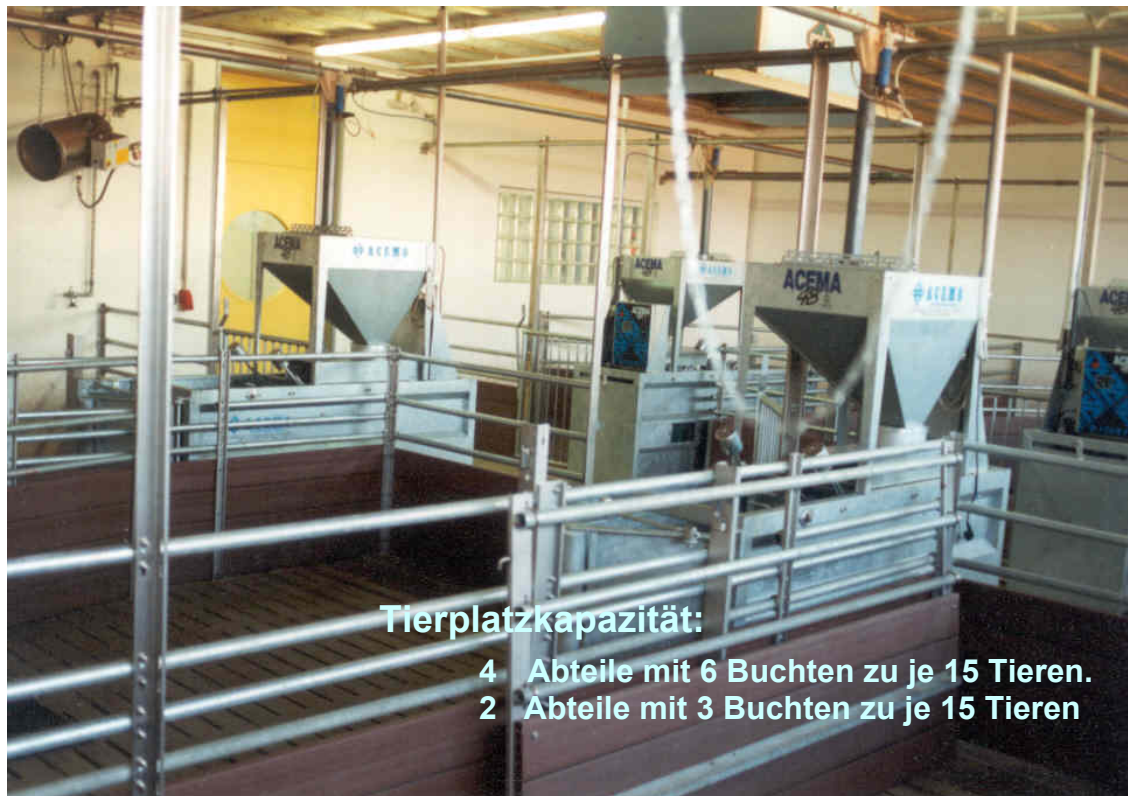
Abbildung 14: Mastabteil im Prüfbereich
