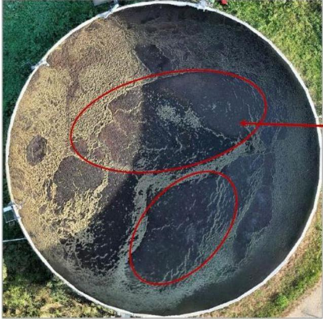
dünne Schwimmschicht mit abgetrockneten Bereichen
