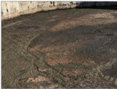
dünne trockene Schwimmschicht, Dicke 3-5 cm
