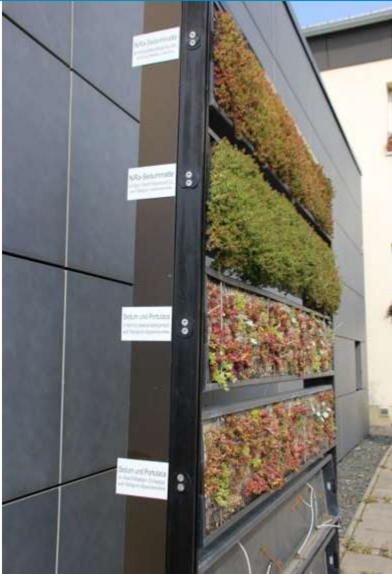
Süd-Seite des Lehrgebäudes
