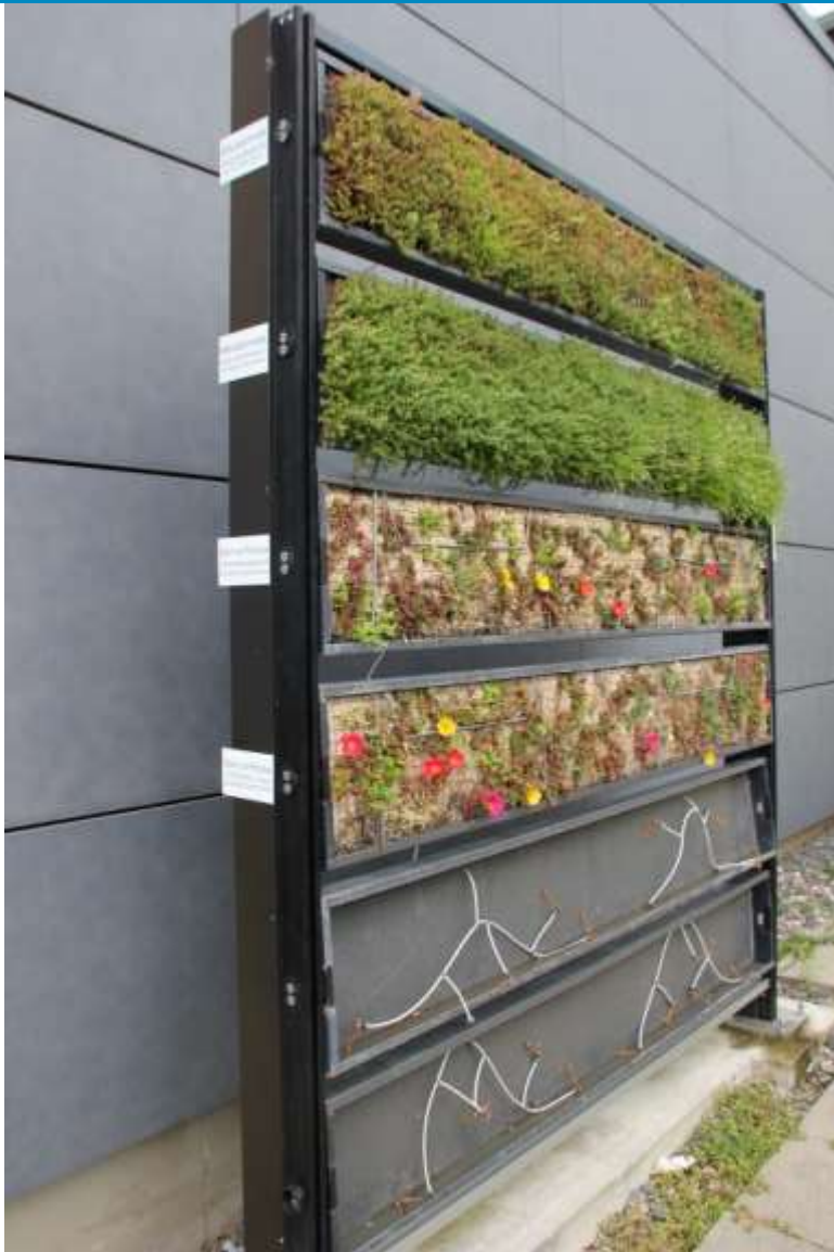
Süd-Seite des Lehrgebäudes
